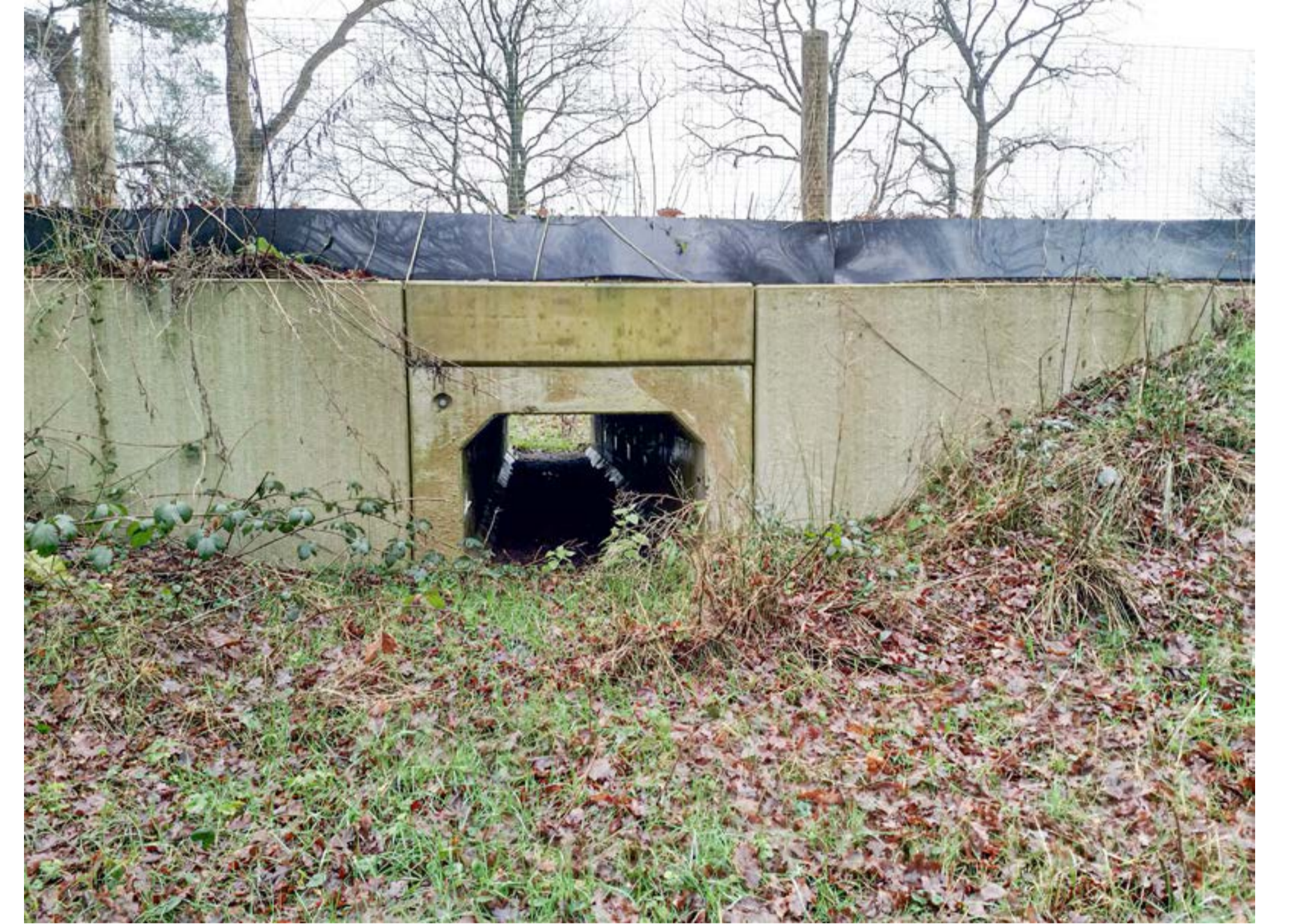
Faunapassages 50x150 cm voor zoogdieren, amfibieën en reptielen - foto's van aanleg en resultaat
