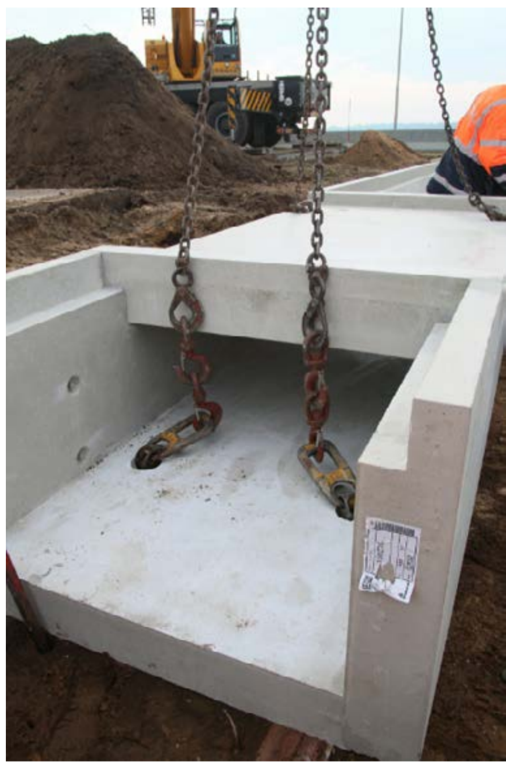
Faunapassages 50x150 cm voor zoogdieren, amfibieën en reptielen - foto's van aanleg en resultaat
